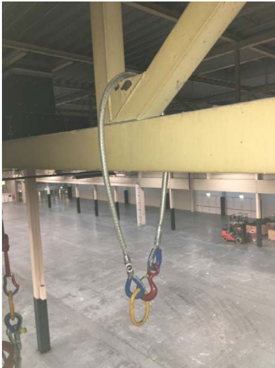
figuur 4: Bevestiging in knoop aan de onderregel (●)
