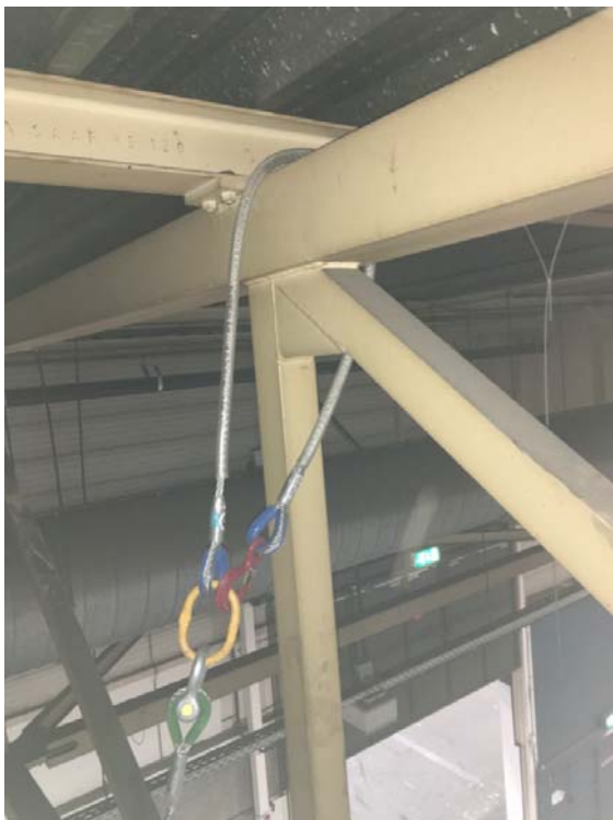
figuur 5: Bevestiging in knoop aan de bovenregel (●)
