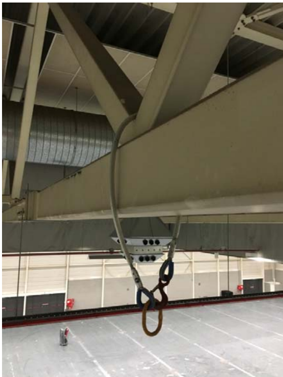
figuur 13: Bevestiging in knoop aan onderregel (●)
