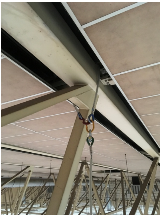
figuur 8: Bevestiging in knoop aan de bovenregel (●)
