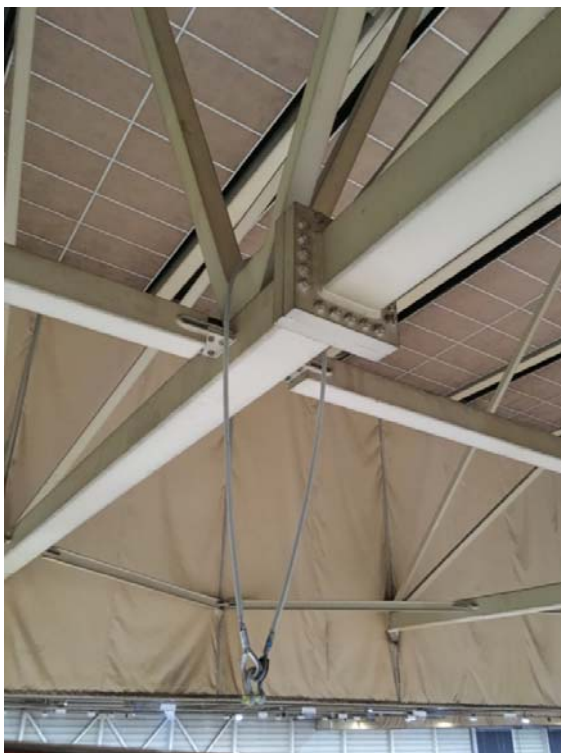
figuur 9: Bevestiging in knoop aan de onderregel (●)
