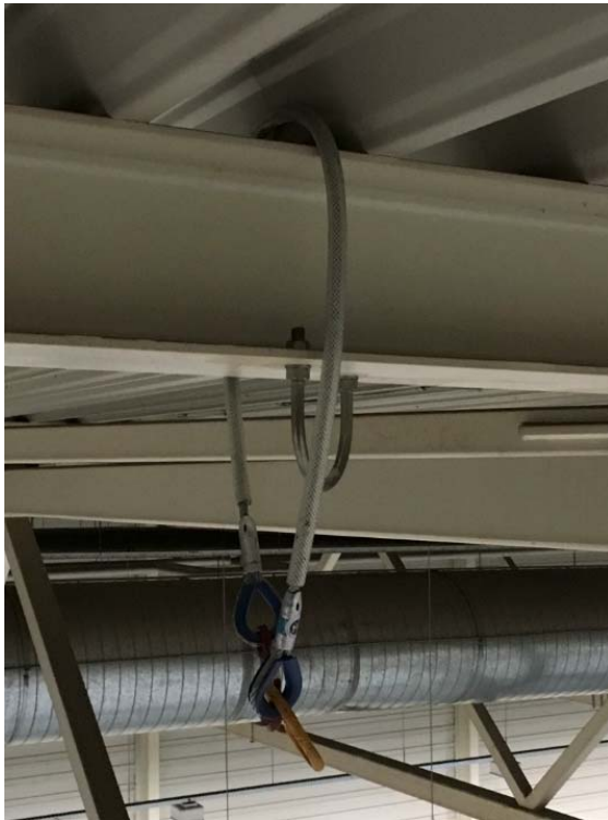
figuur 12: Bevestiging t.p.v. ophangpunten gordingen (●)
