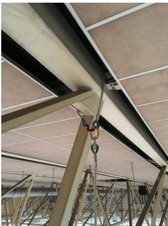
figuur 8: Bevestiging in knoop aan de bovenregel (●)
