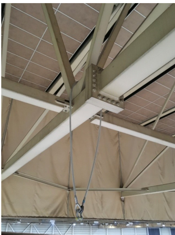
figuur 9: Bevestiging in knoop aan de onderregel (●)
