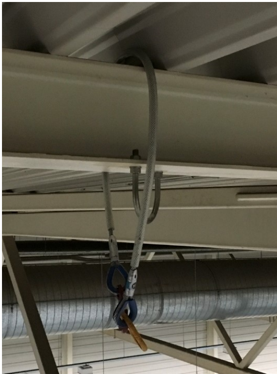
figuur 12: Bevestiging t.p.v. ophangpunten gordingen (●)
