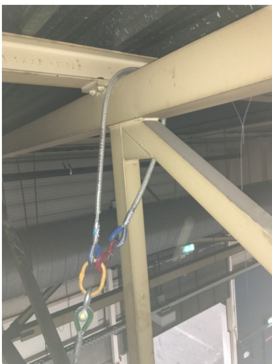
figuur 5: Bevestiging in knoop aan de bovenregel (●)
