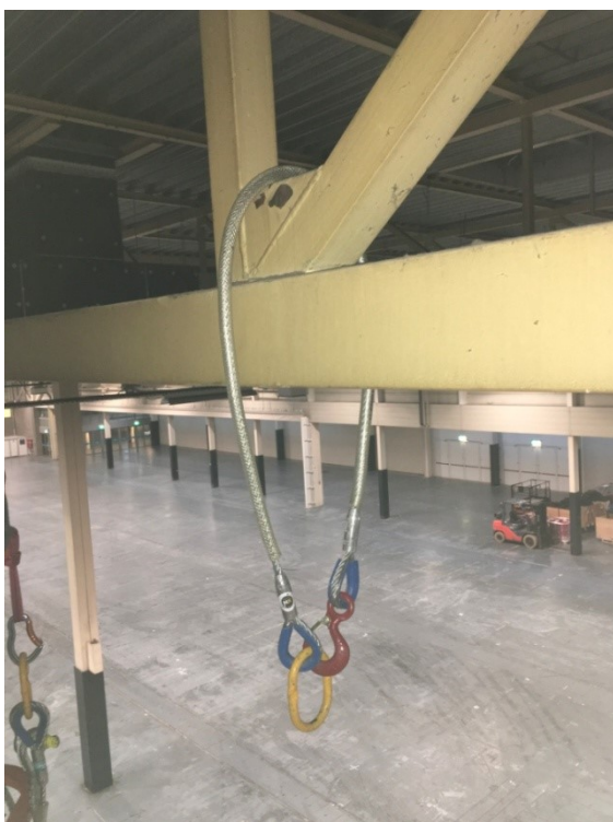
figuur 4: Bevestiging in knoop aan de onderregel (●)
