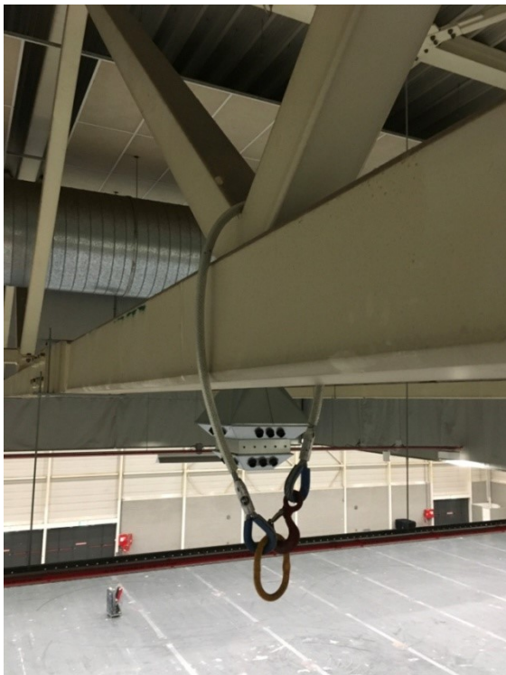
figuur 13: Bevestiging in knoop aan onderregel (●)
