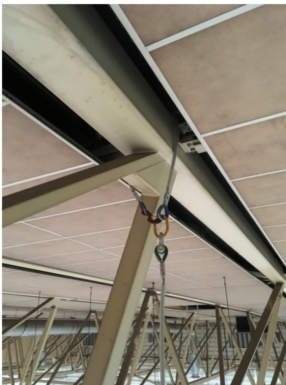
figuur 8: Bevestiging in knoop aan de bovenregel (●)
