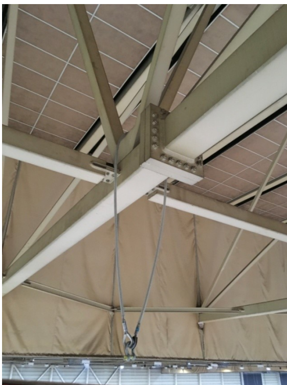
figuur 9: Bevestiging in knoop aan de onderregel (●)
