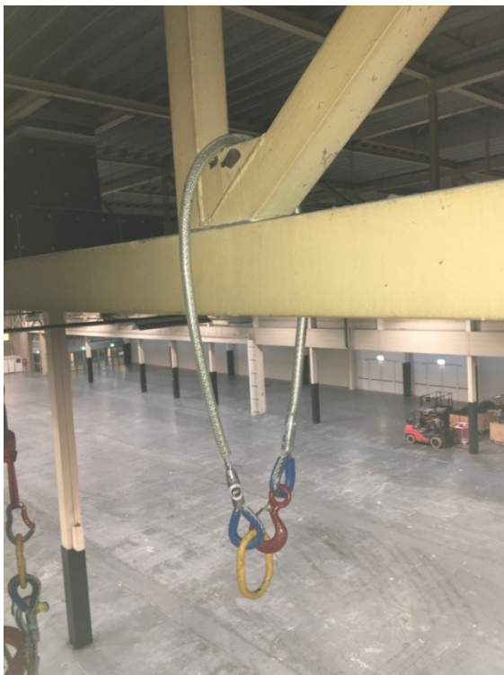
figuur 4: Bevestiging in knoop aan de onderregel (●)
