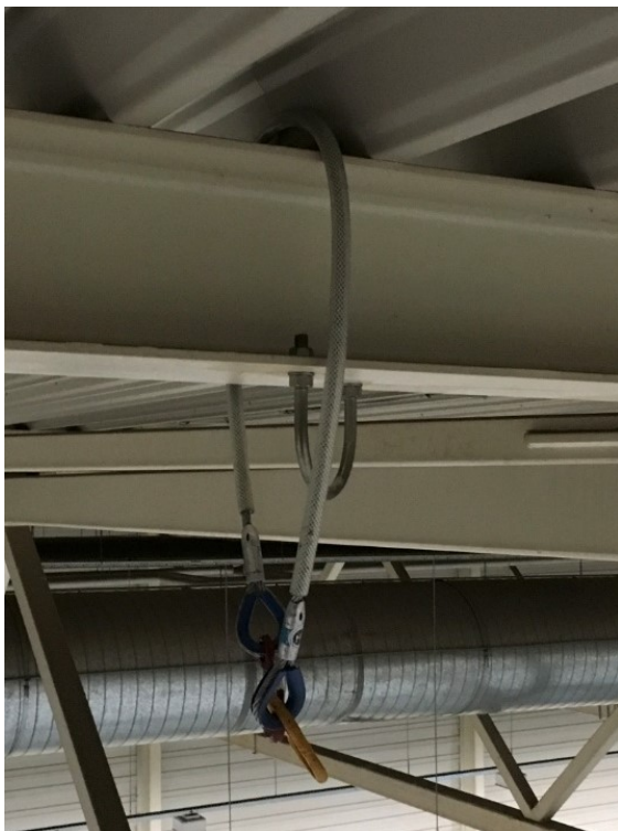
figuur 12: Bevestiging t.p.v. ophangpunten gordingen (●)
