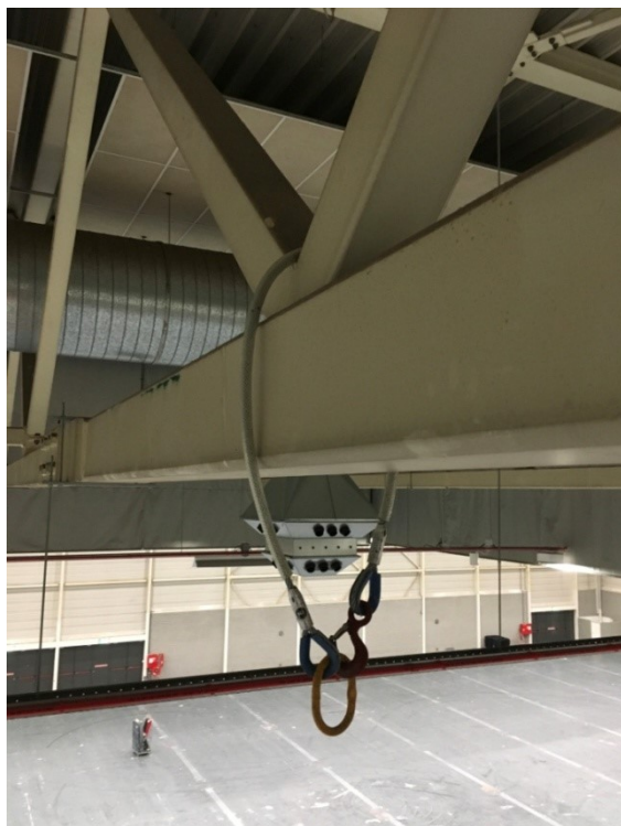
figuur 13: Bevestiging in knoop aan onderregel (●)
