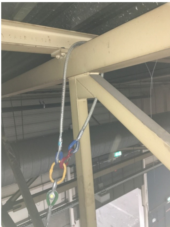
figuur 5: Bevestiging in knoop aan de bovenregel (●)
